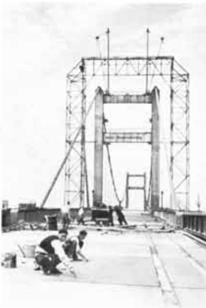
Abb. 162. Herstellung der Fahrbahn.
