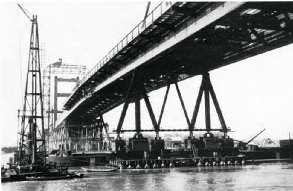
Abb. 120. Aufstellung des Stahlbaues.
