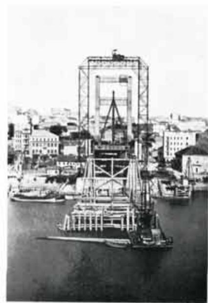
Abb. 92. Aufstellung des Stahlbaues
