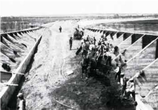
Abb. 74. Bewehrte Winkelstützmauern des Strassendamms
