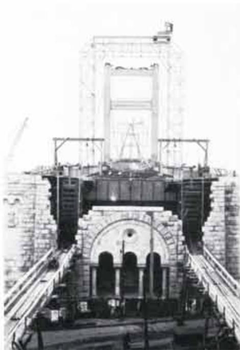
Abb. 67. Ansicht vom Pfeiler V gegen Pfeiler IV mit den Kabelverankerungen, 9. November 1933.
