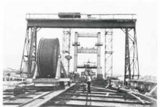
Abb. 136. Auslegen der Kabel zum Recken und Ablängen.
