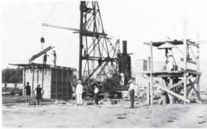
Abb. 61. Tragfähigkeitsversuch mit einem Eisenbetonpfahl
