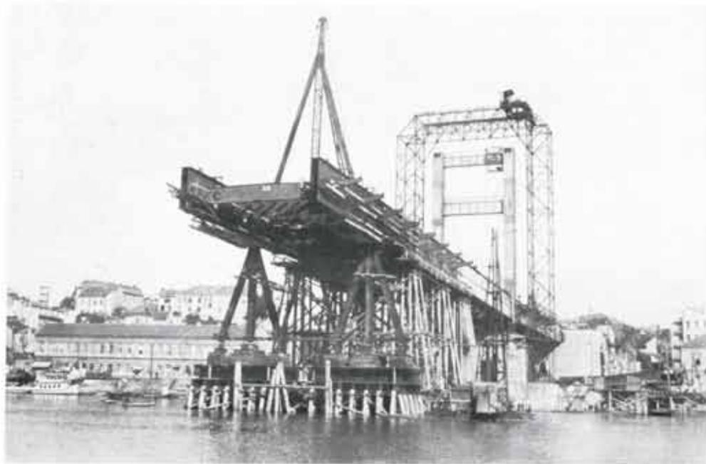
Abb. 116. Aufstellung des Stahlbaues, Seite Beograd.
