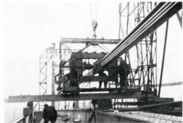
Abb. 155. Anpressen der Kabelschellen vermittelst
