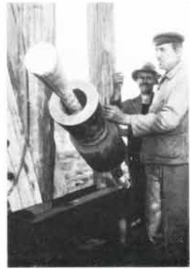
Abb. 139. Fertig ausgegossener Seil-Verankerungskopf nach erfolgter Reckung und Ablängung.
