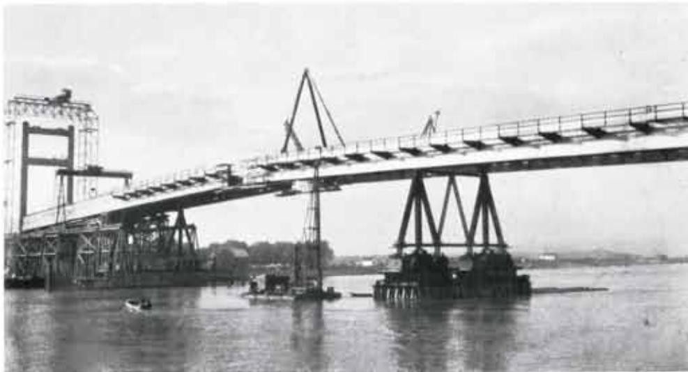
Abb. 118. Aufstellung des Stahlbaues.
