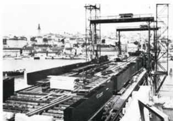
Abb. 88. Aufstellung des Stahlbaues, Seite Zemun.
