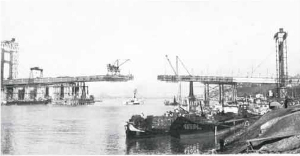
Abb. 117. Aufstellung des Stahlbaues.
