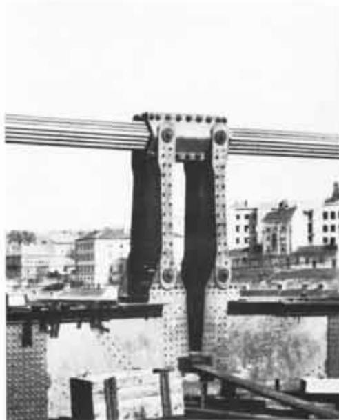
Abb. 28. Doppelaufhängung der Fahrbahn
