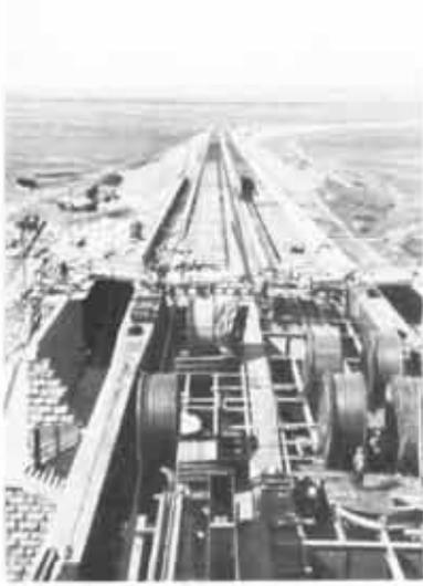
Abb. 137. Auslegen und Recken der Kabel am linksufrigen Eisenbetonviadukt und Damm.
