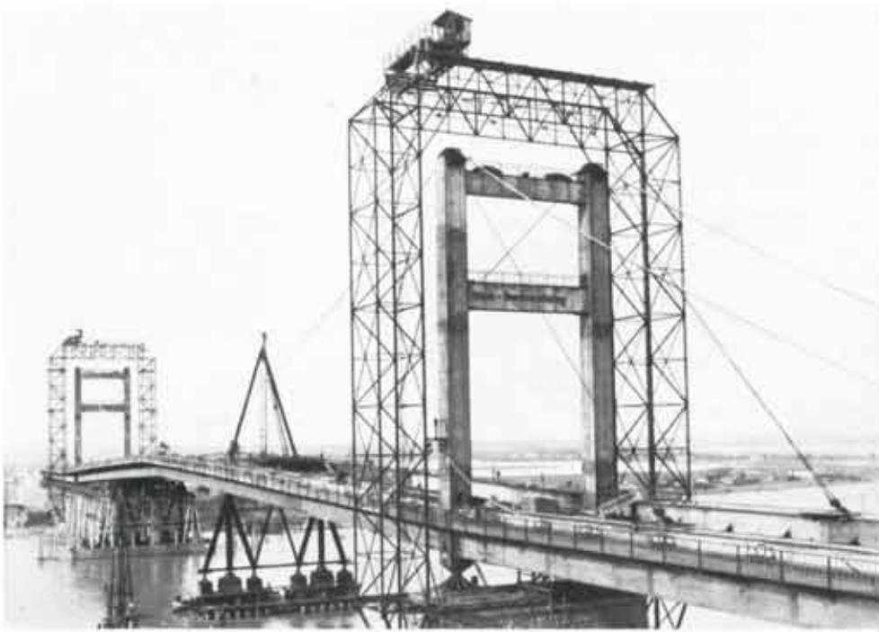
Abb. 121. Aufstellung des Stahlbaues.
