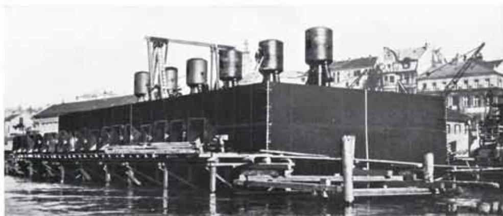
Abb. 55. Flusspfeiler III. Senkkasten  $16 \times 40$  m, unmittelbar vor der Absenkung.
