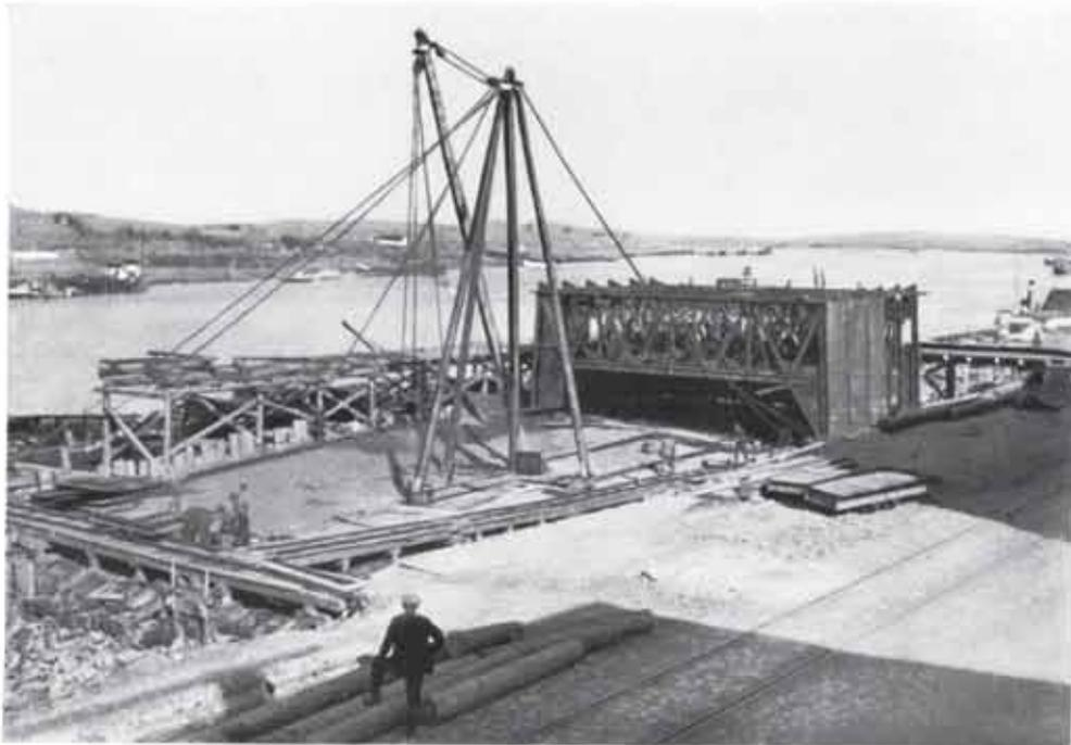
Abb. 54. Flusspfeiler III. Aufstellung des Senkkastens. 10. September 1930.
