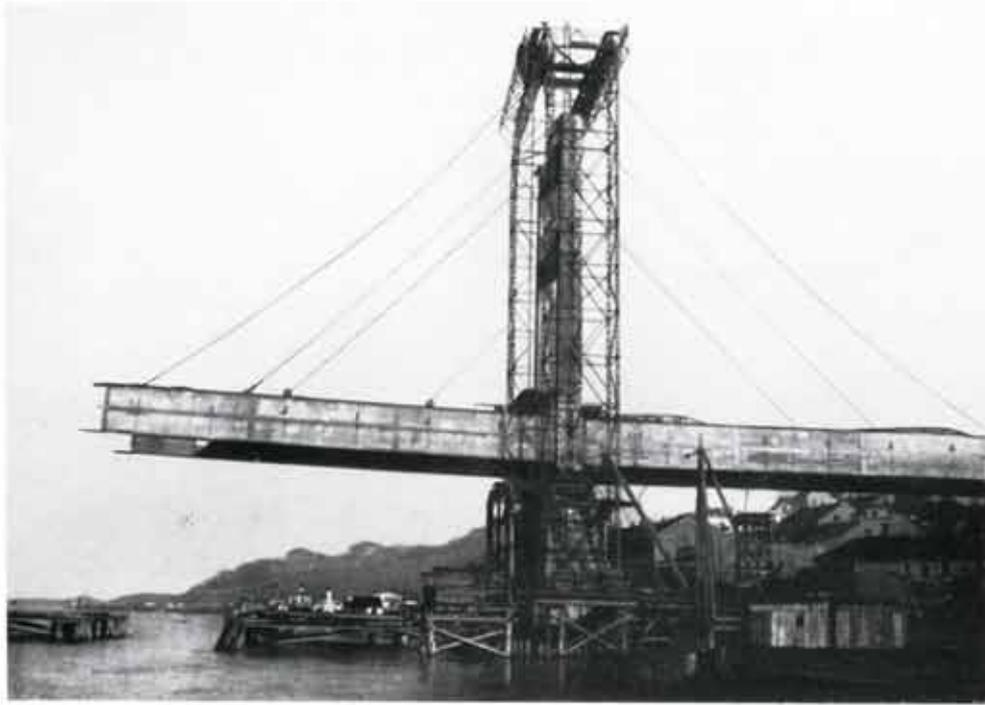
Abb. 107. Bauzustand, Seite Beograd, bei Wiederaufnahme der Arbeit,
