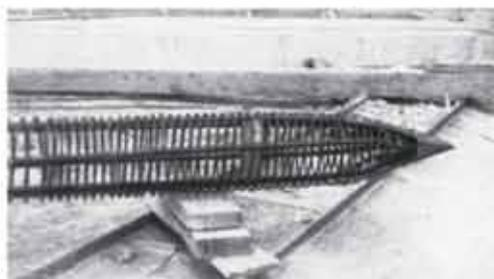
Abb. 59 und 60. Bewehrungsgerippe der Eisenbetonpfähle.
