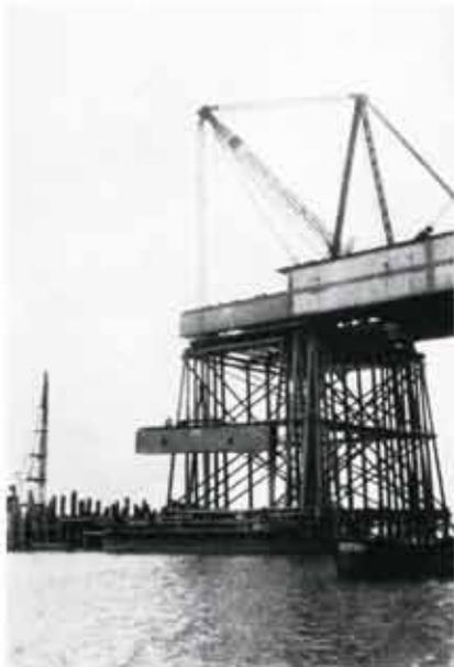
Abb. 95. Aufstellung des Stahlbaues
