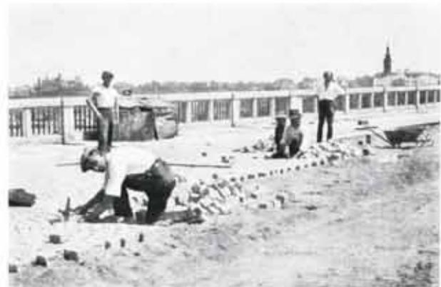
Abb. 168. Herstellung der Fahrbahn.
