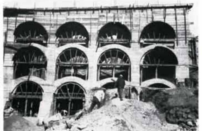
Abb. 75. Aufgelöste Betonstützmauer gegen die
