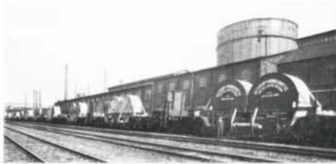
Abb. 134. Versand der Kabel von Gelsenkirchen nach Regensburg auf Sonder-Tiefladewagen; jeder Wagen mit zwei Haspeln von 3,5 m Durchmesser beladen.
