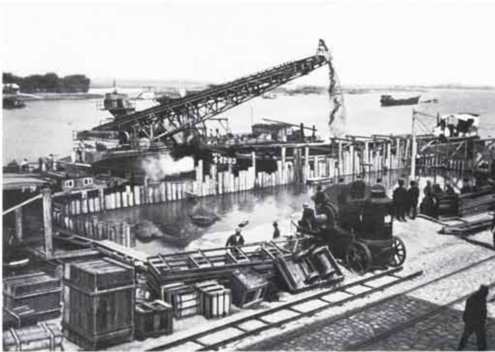
Abb. 53. Flusspfeiler III. Kiesaufschüttung zwischen Holzspundwänden zum Aufstellen des eisernen Senkkastens. 20. August 1930.
