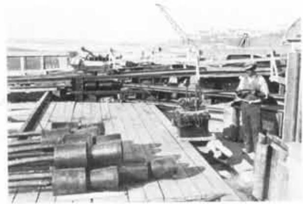
Abb. 141. Recken und Ablängen der Seile.
