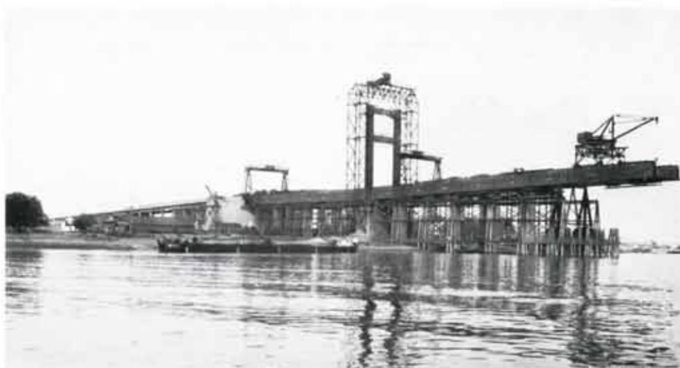
Abb. 110. Aufstellung des Stahlbaues, Seite Zemun.
