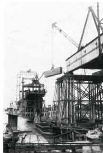
Abb. 96. Aufstellung des Stahlbaues
