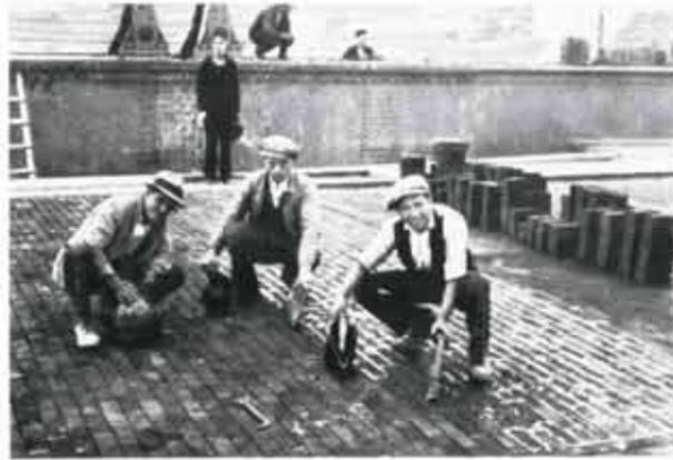
Abb. 166. Herstellung der Fahrbahn.
