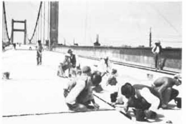
Abb. 161. Herstellung der Fahrbahn.
