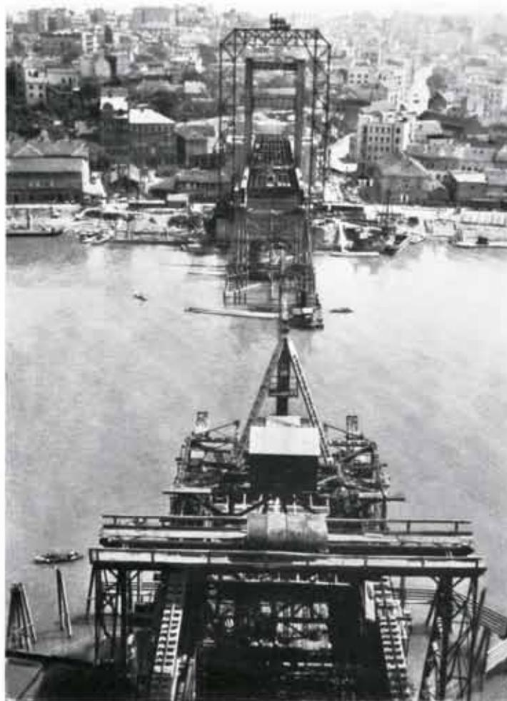
Abb. 108. Aufstellung des Stahlbaues.
