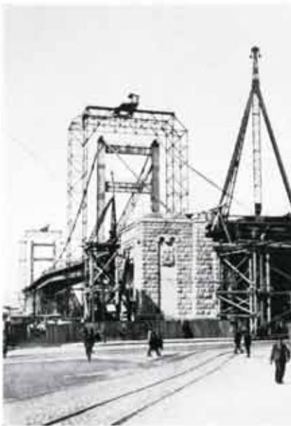
Abb. 105. Aufstellung des Stahlbaues.
