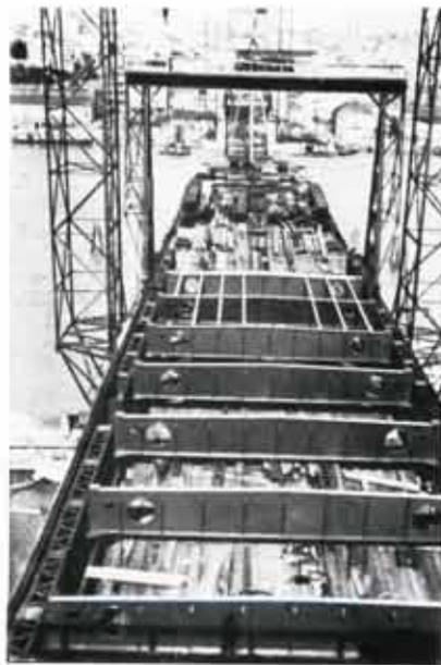
Abb. 91. Aufstellung des Stahlbaues
