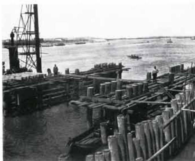
Abb. 87. Pfahlrost zur Aufnahme der rechtsufrigen
