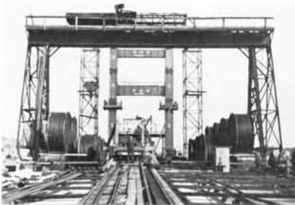
Abb. 135. Auslegen der Kabel zum Recken und Ablängen.
