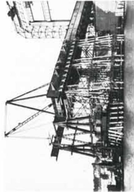
Abb. 101. Aufstellung des Stahlbaues, Seite Beograd.
