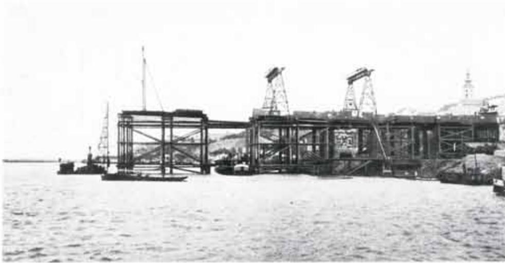
Abb. 79. Aufstellung des Stahlbaues, Seite Beograd.
