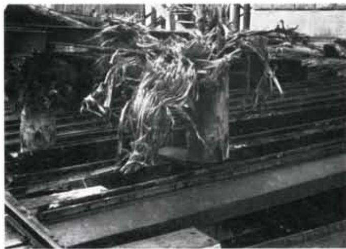
Abb. 132. Zerfaserte Spitzen der bis auf den Kalkstein
