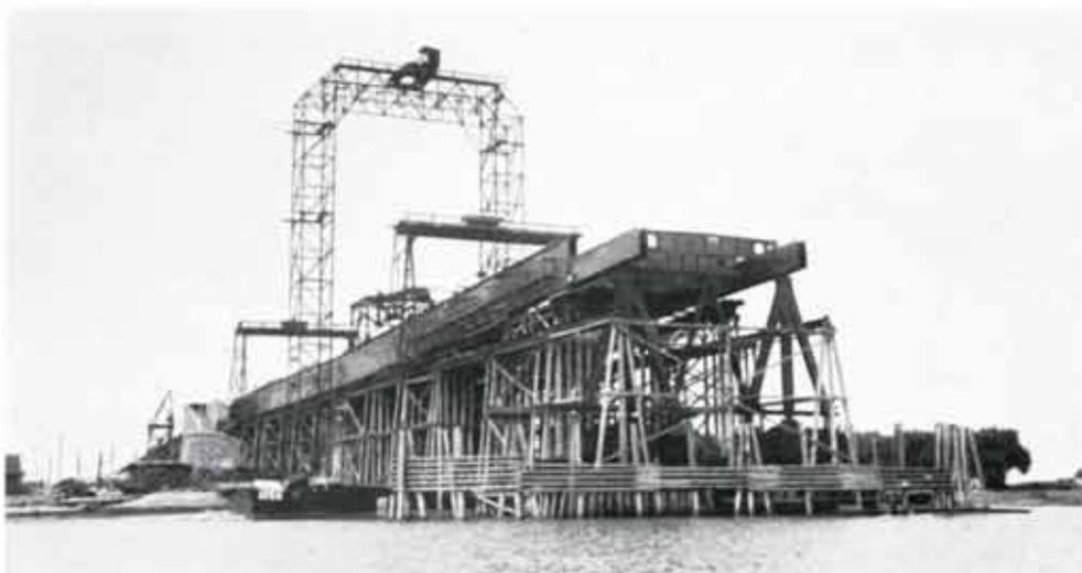
Abb. 109. Aufstellung des Stahlbaues, Seite Zemun.
