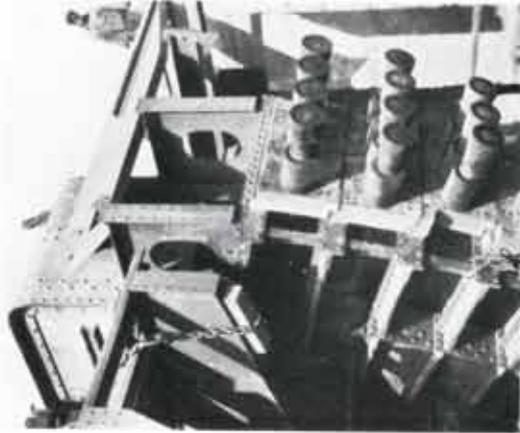
Abb. 148. Verankerung der Einzel-seile des Tragkabels in das Pistolenende des Versteifungsträgers.
