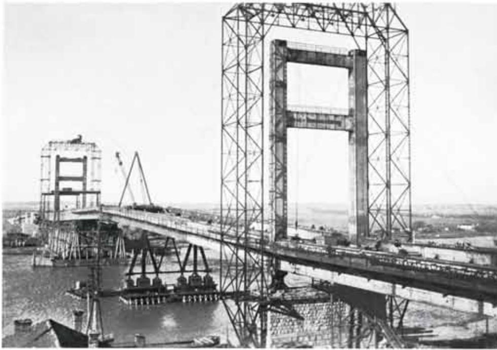
Abb. 119. Aufstellung des Stahlbaues.
