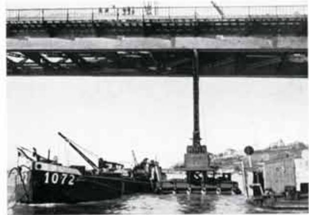
Abb. 104. Aufstellung des Stahlbaues, Seite Beograd.
