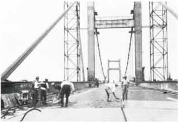
Abb. 160. Herstellung der Fahrbahn.
