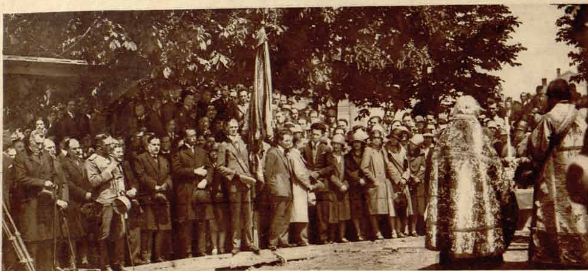
Освећење темеља Студентског Дома. — Osvećenje temelja Studentskog Doma.
