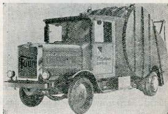
Сл. 17. — Аутомобил за сметлиште фирме „Faun“
