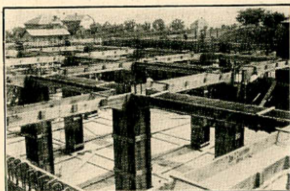
Нови резервоар на Дедињу у грађењу
