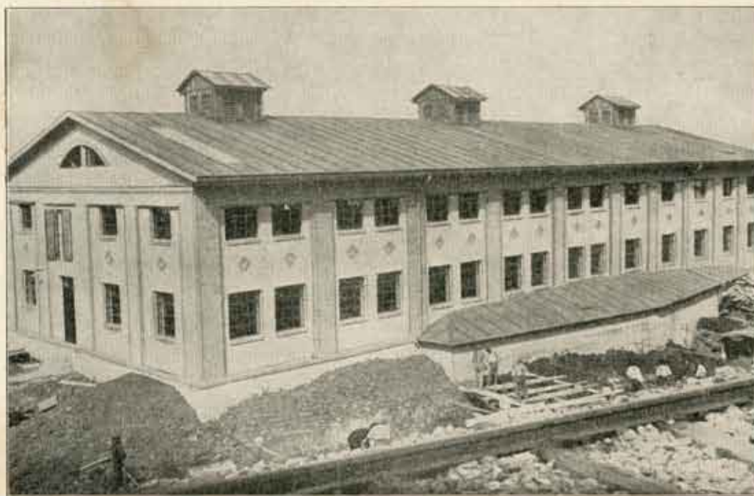
Фабрички водовод – приземље, са магацином за сиров материјал на спрату. Водовод снабдева фабрику са 12.000.000 литара дневно савске воде. Магацин прима до 100 вагона сировине;
