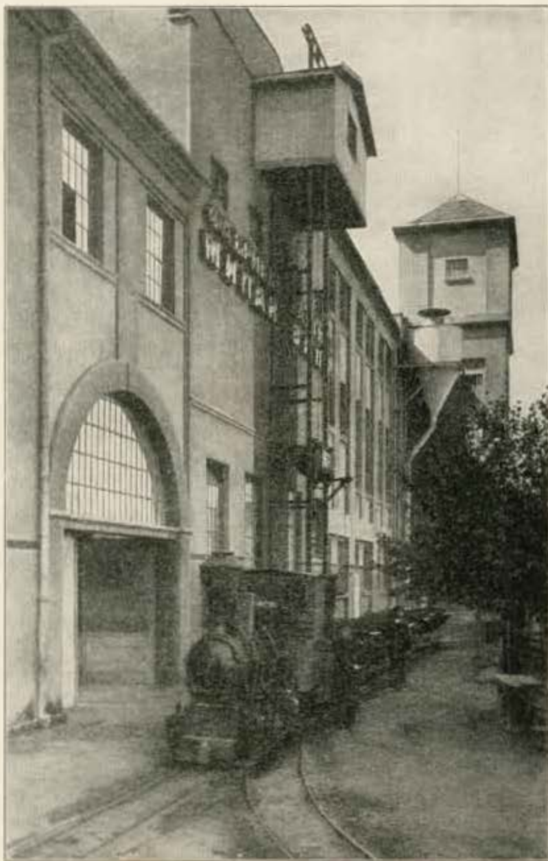
Пренос угља и пуњење силоса сваких 24 сата 4-5 вагона угља
