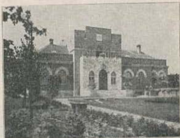
Нова зграда Отсека за паркове Београдске општине
