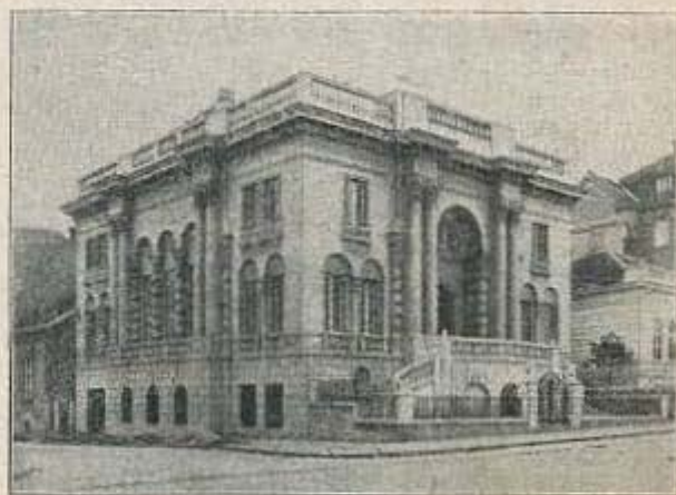
Сл. 3. — Вила у ул. Књегине Персиде бр. 51
