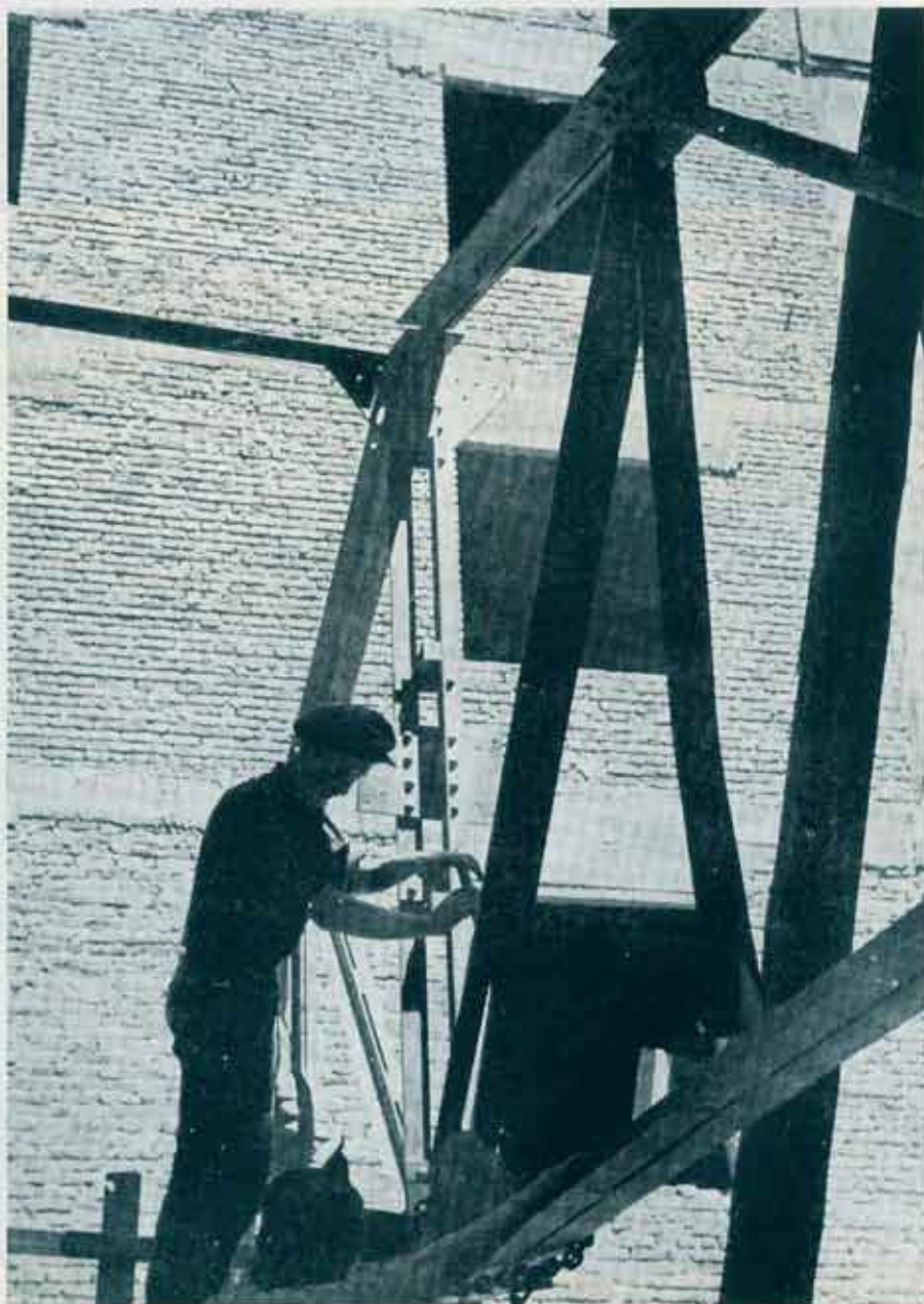
Монтажа гвозденог крова.
