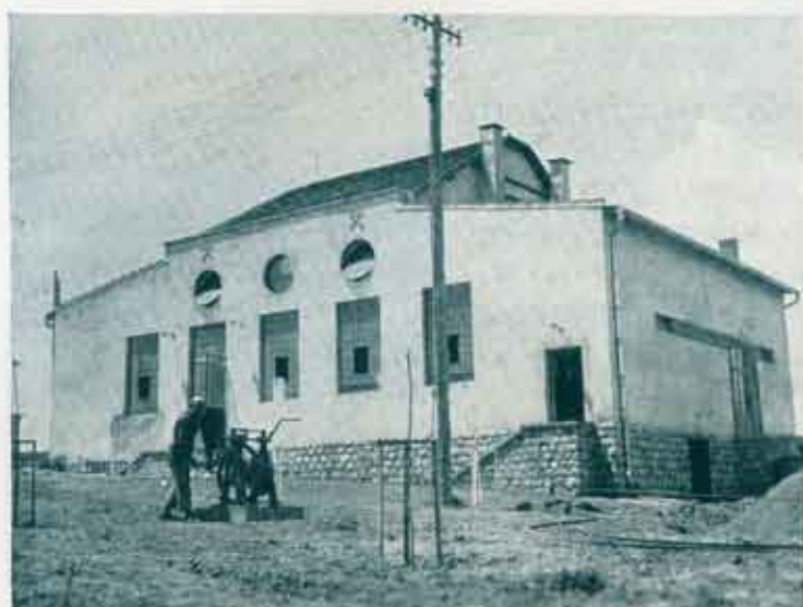
Нова електрична централа.
