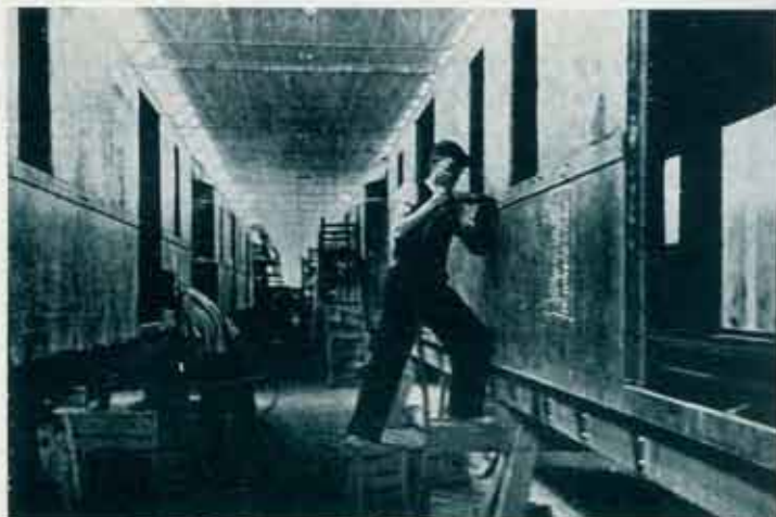
Пнеуматичко закивање (нитовање) вагона.
