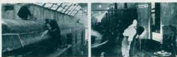
Радови по првобитном, главном програму фабрике: грађење вагона, заваривање (швајцовање).
