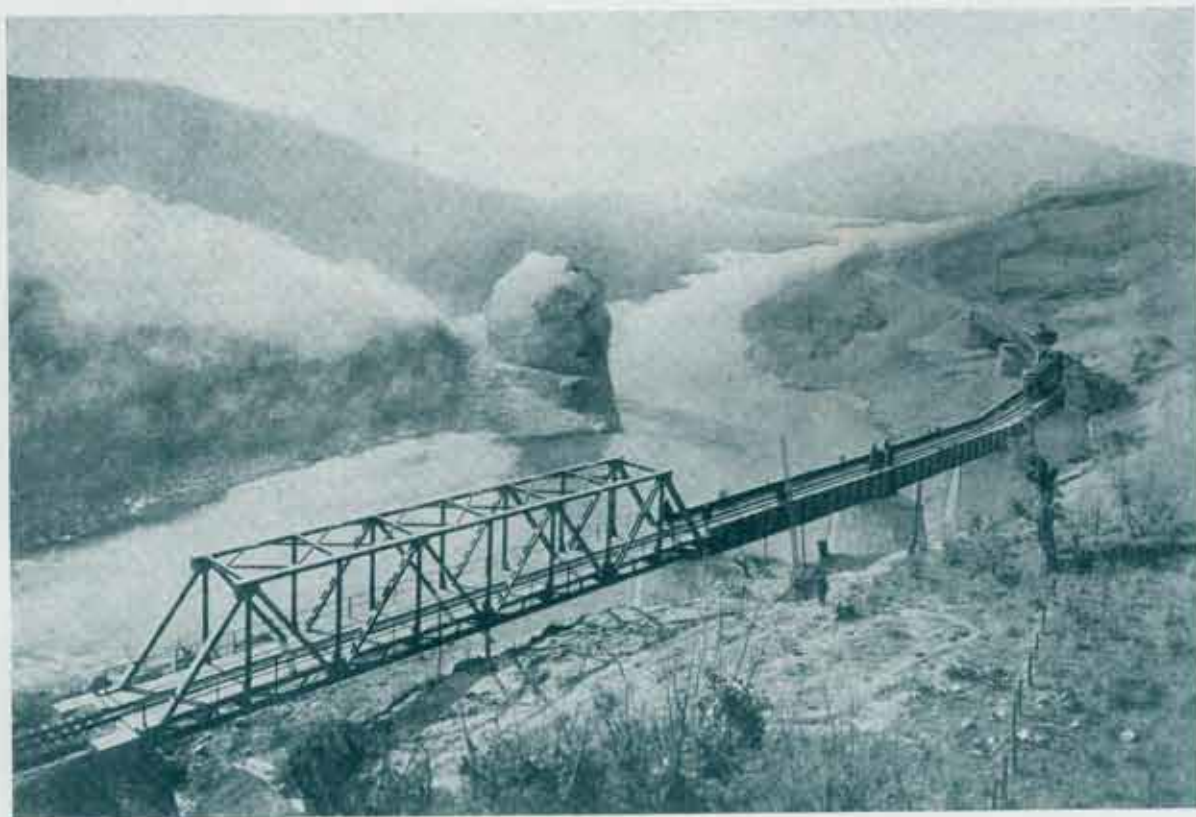
Пробно оптерећење моста на прузи Устипрача-Фоча.
