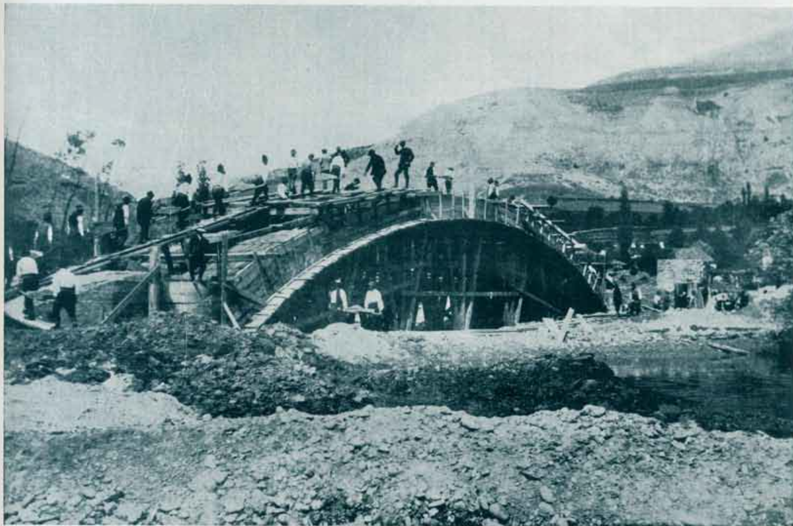
Армирано-бетонски мост од 30 м. распона на км. 43+180 (год. 1912).
