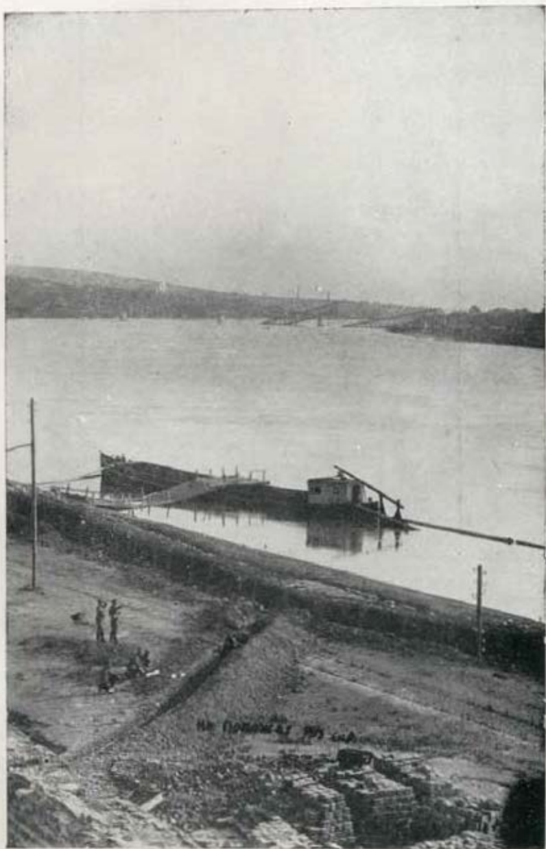
Прилазница и ровови на Одсеку 1 чете 2 бат. X кадр. пука на Сави, са порушеним гвозденим мостом.
