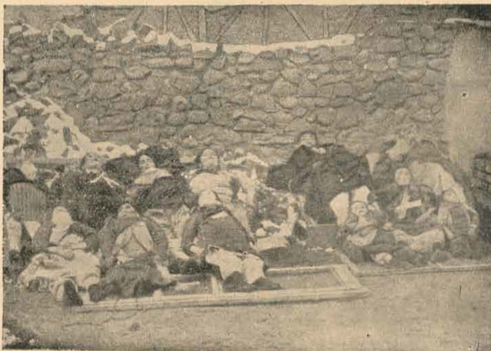
Жртве отрозане загушљивим гасом приликом бомбардовања Београда
