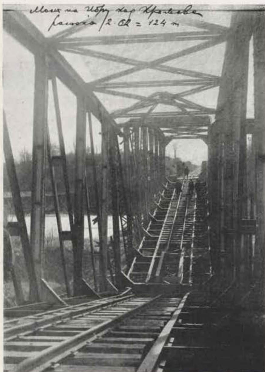
Ligne Stalatch-Krouchévats-Oujitsé. Sur l'Ibar, près de Kraliévo : pont en fer de 124 mètres de longueur (deuxième travée).
