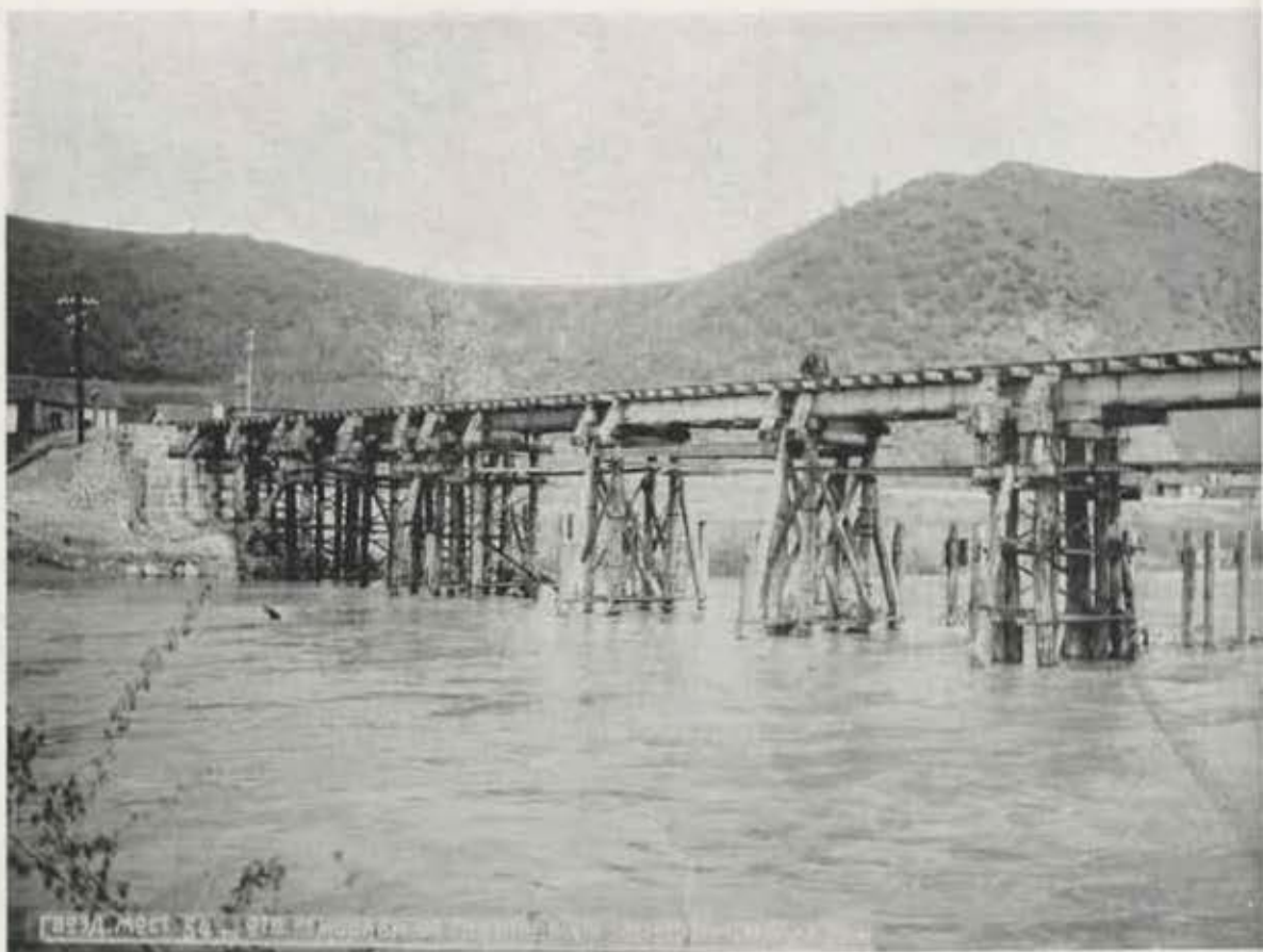
Ligne Belgrade-Nich-Vranié, 302 km. 550. Sur la rivière Morava, à Grdelitsa : pont en fer de 54 mètres de longueur et tra- vaux provisoires de réparations.
