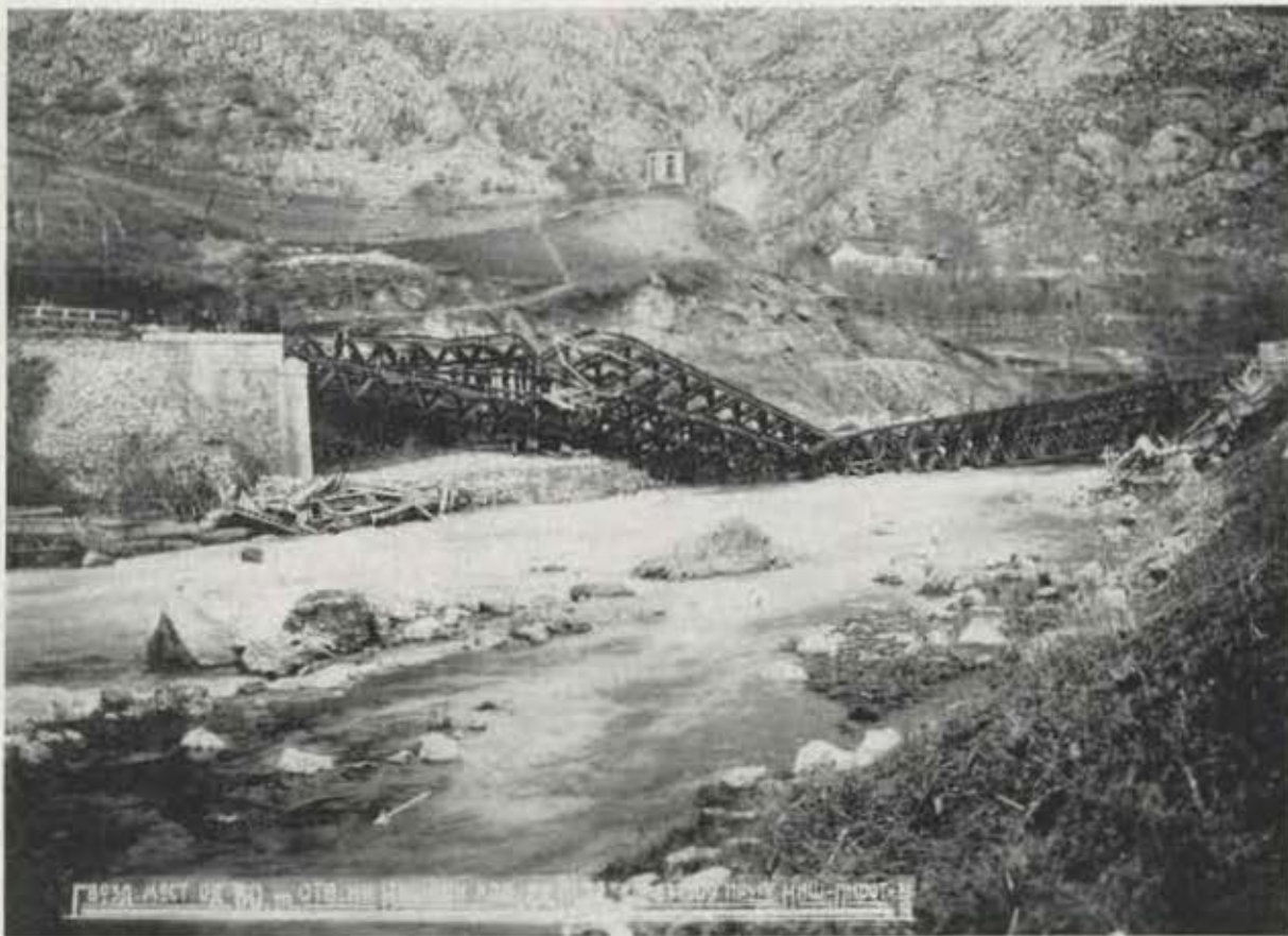
[Ligne Nish-Pirot, 23 km. 500. Pont en fer de 60 mètres de longueur détruit, sur la rivière Nishava.
