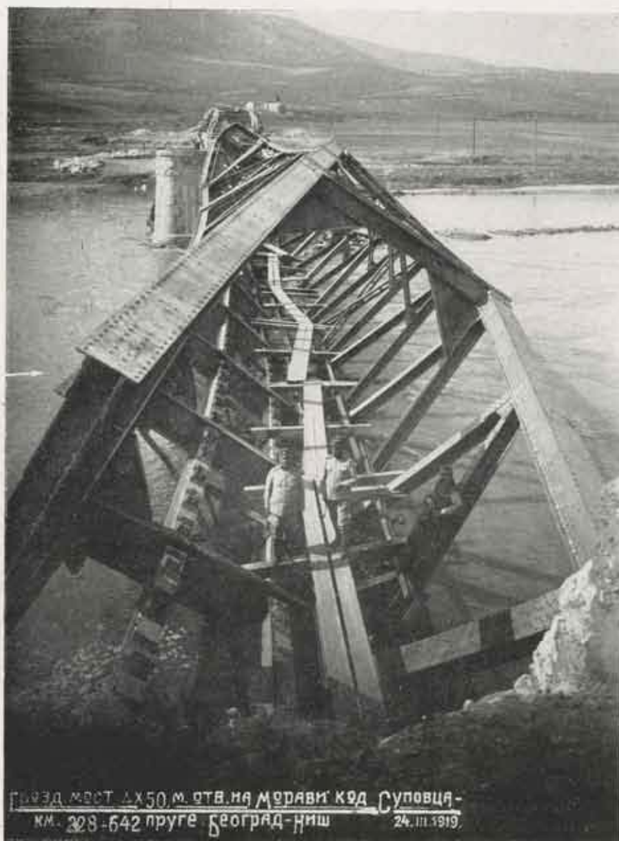
Ligne Belgrade-Nish, 228 km. 642. Sur la rivière Morava, près de Soupovats : pont en fer de 4 \times 50 = 200 mètres.
