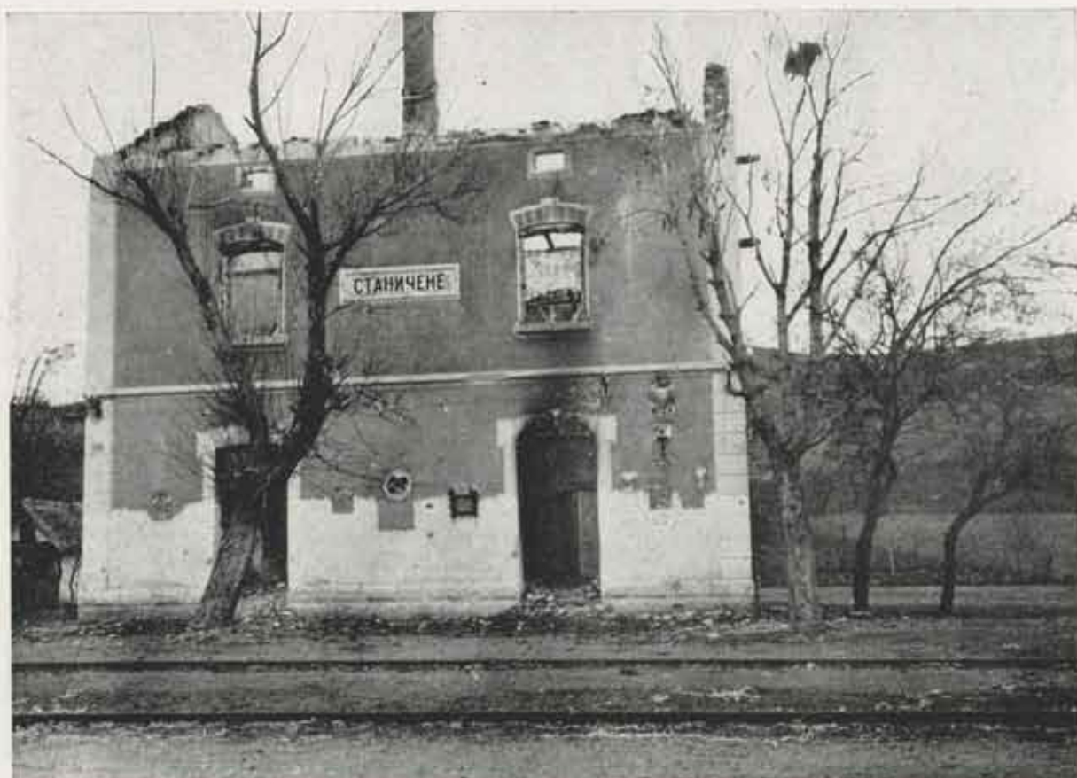
Ligne Nish-Pirot, 63 km. 800. Gare de Stanitchénié, pillée et incendiée.
