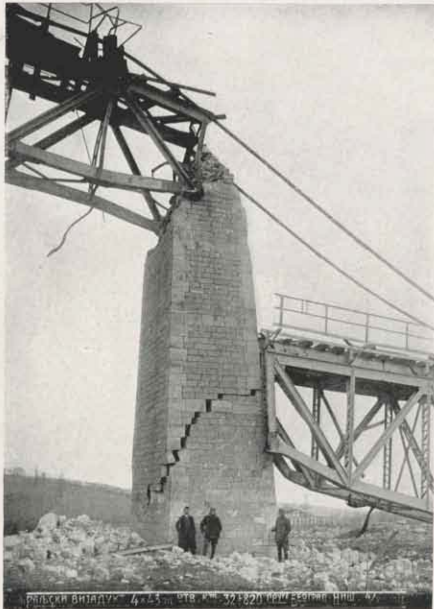
Ligne Belgrade-Nish, 32 km. 820. Viaduc de 4 \times 43 de longueur.
