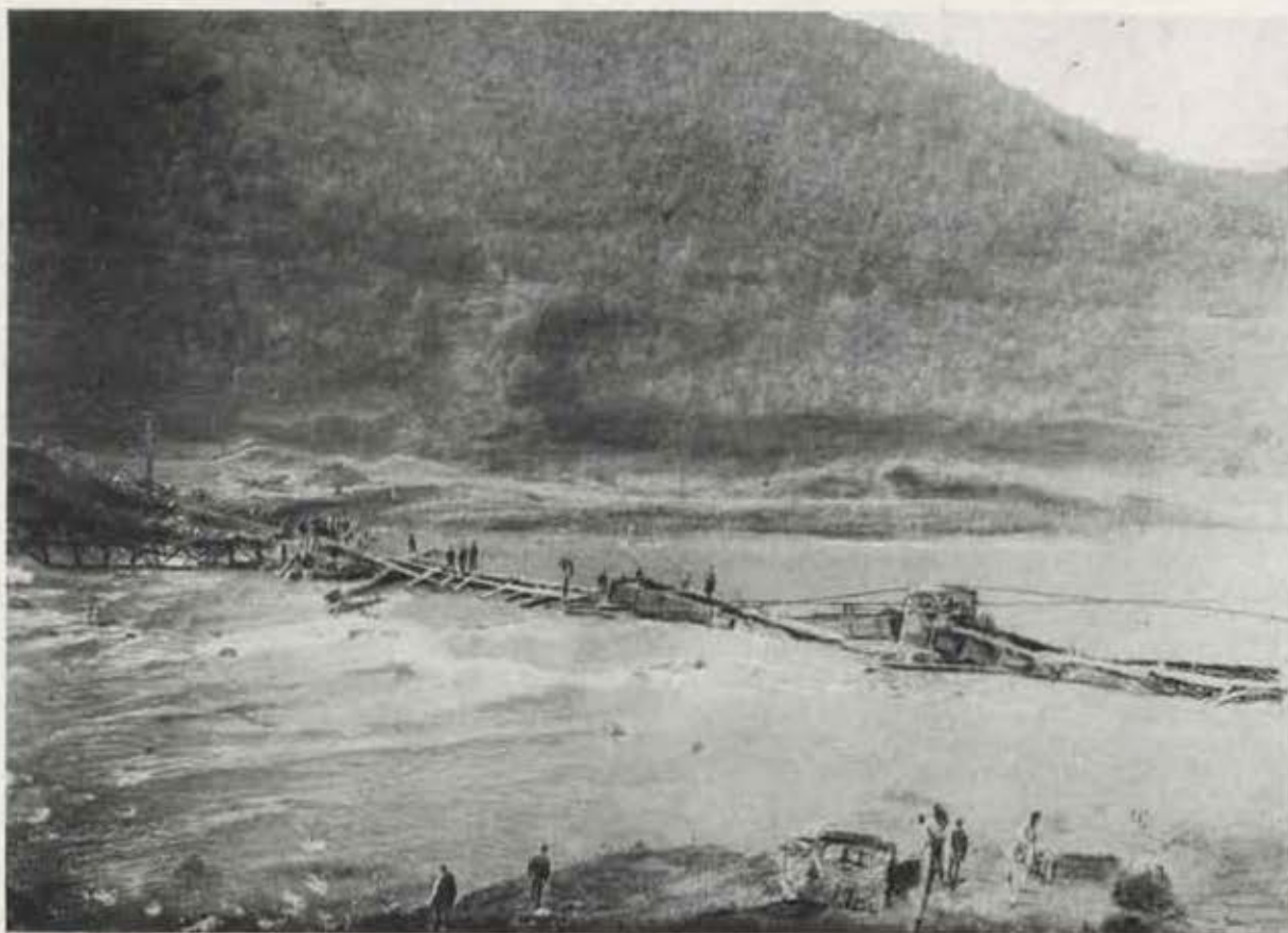
Ligne Salonique-Skoplië, 215 kilomètres. A Zelenikovo : pont en fer de 4 \times 17,5 = 60 mètres de longueur.
