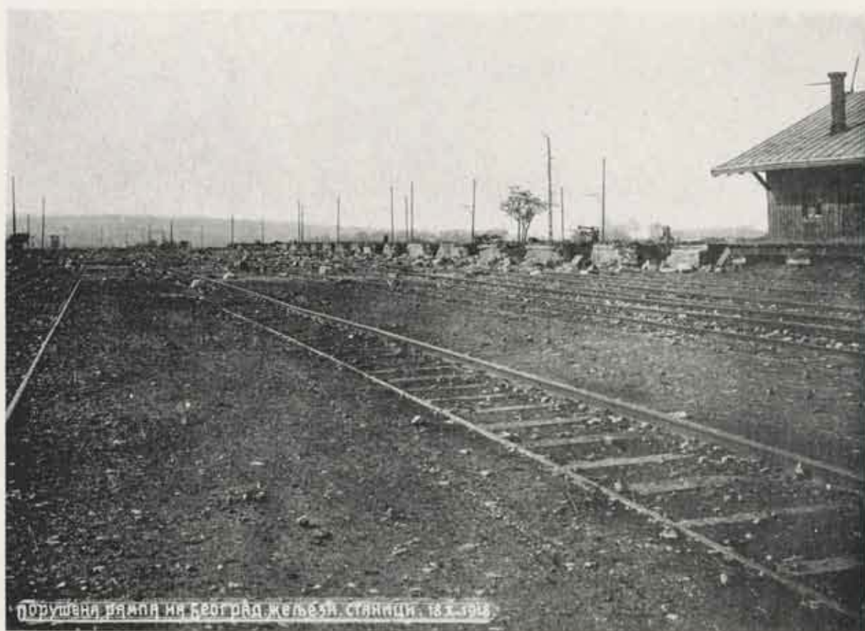
Ligne Belgrade-Nish. Gare de Belgrade : plateformes de chargement détruites, cas typique de destruction de plateformes.
