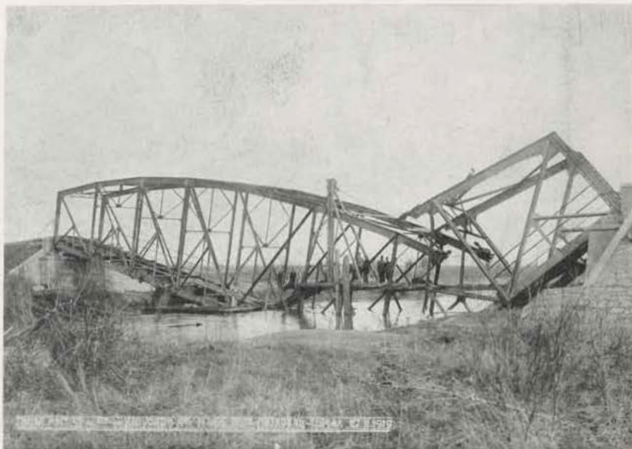
Ligne Laïkovats-Tchatchak, 1 km. 455, Sur la Koloobara. Pont en fer de 52 mètres de longueur détruit.
