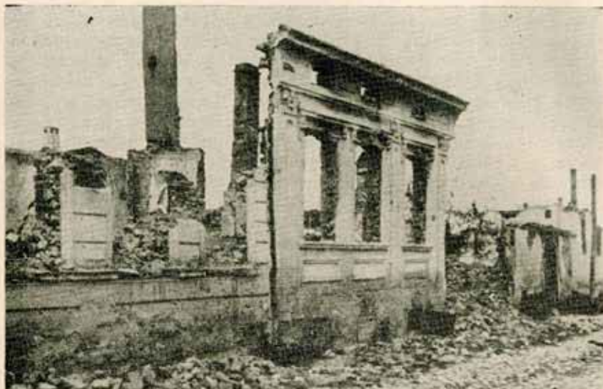
Изглед порушене Дунавске улице
