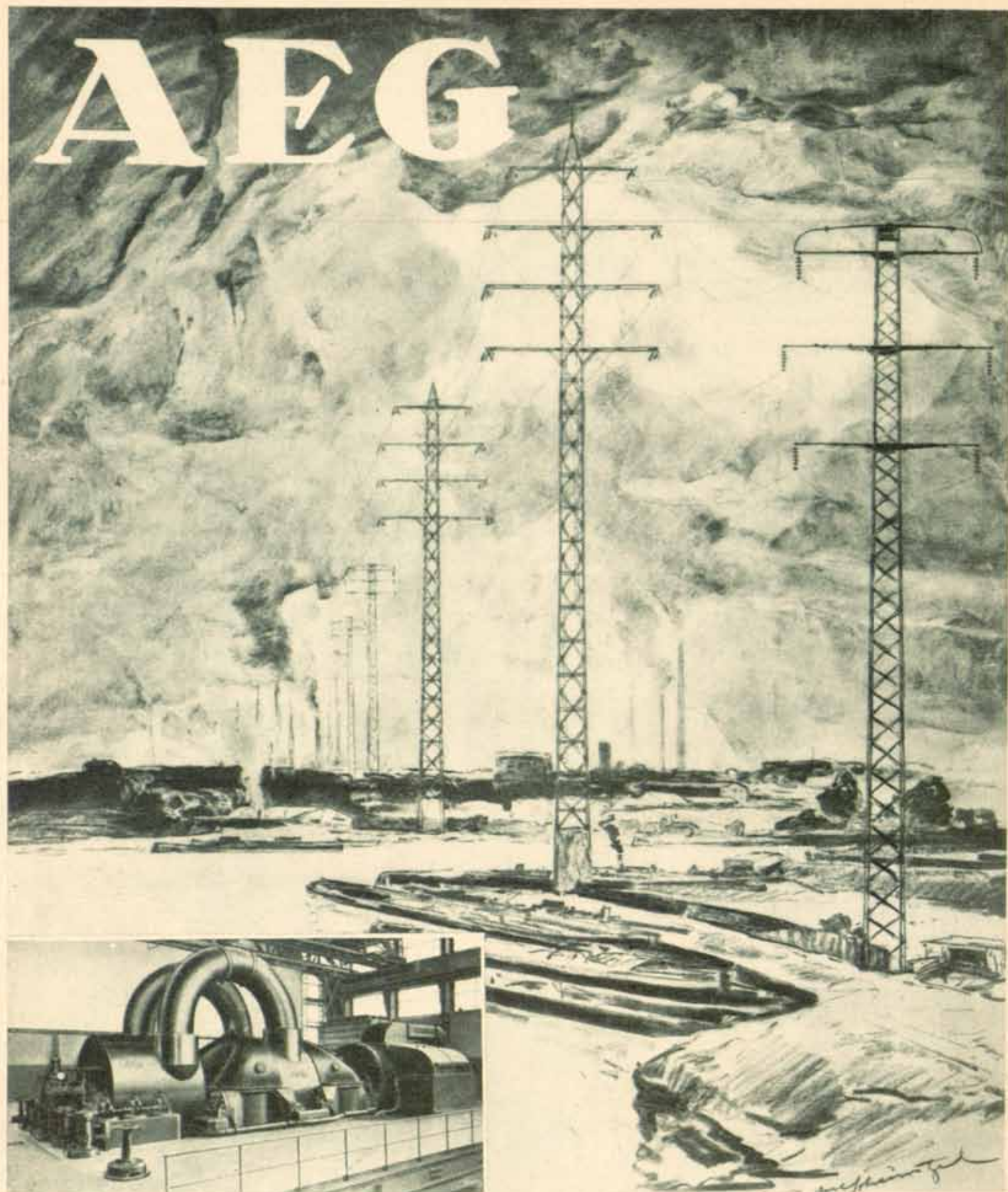
AEG парна турбина од 85.000 киловата монтирана у електричној централы Порнебиц. У погону од 20. нов. 1929.
